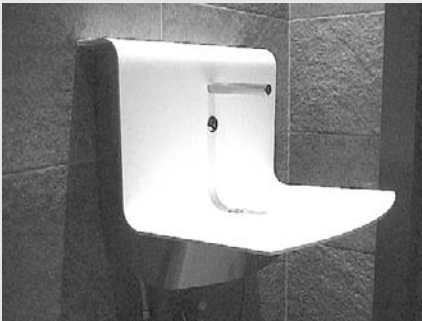
Lavabo hospitalier supprimant les problèmes de légionelles (bactéries) en chauffant l'eau grâce à un chauffe-eau intégré.
