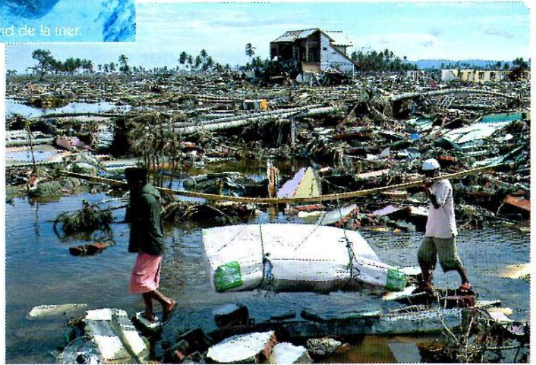
Les dégâts du raz de marée (tsunami) de décembre 2004 (Banda Aceh, Indonésie).
