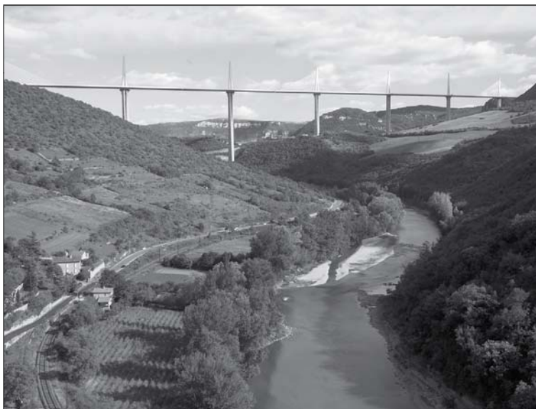
△ Grand Viaduc du Millau
