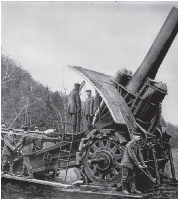
Der Erste Weltkrieg war der erste mit **Massenvernichtungswaffen** geführte Krieg. Die Reichweite der Geschütze reichte bis zu 60 km. Im Bild das Geschütz „Gamma-Gerät“, Kaliber 42 cm
