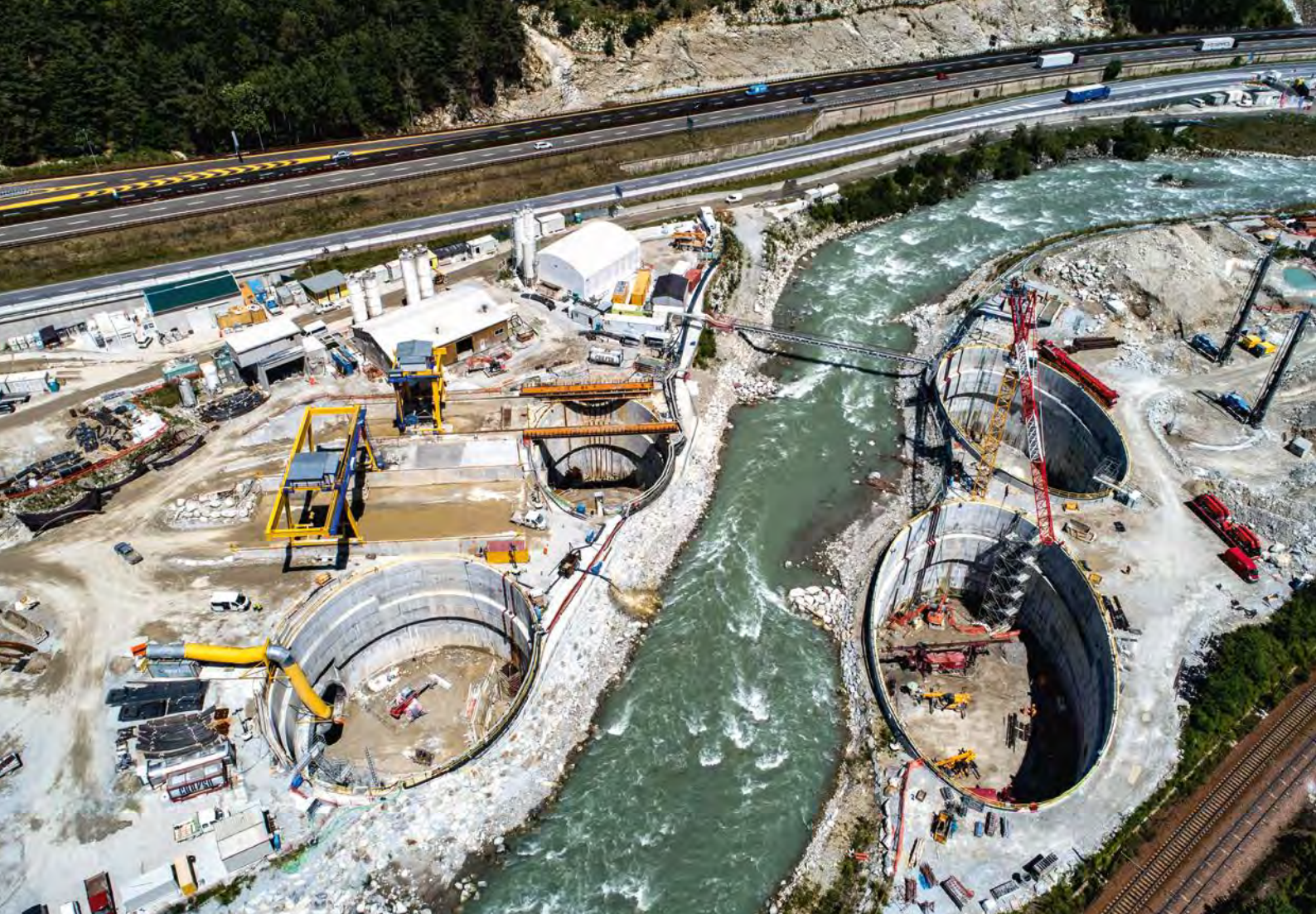
Mit einem komplexen Prozess bauen die Ingenieure auch Tunnel unter dem Fluss Eisack durch.
