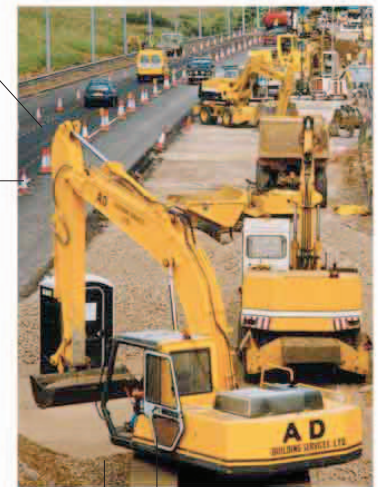
der Bagger excavator
