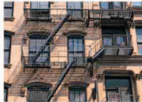
die Feuertreppe fire escape
