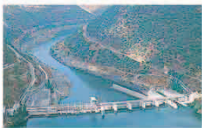
der Staudamm dam
