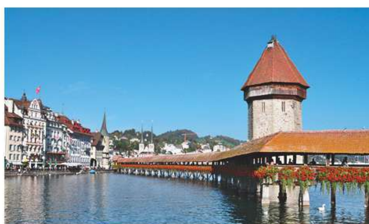
4 die Kapellbrücke, Luzern (CH)
