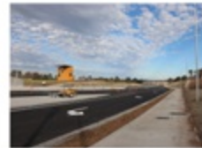
La salida de la autopista Off-ramp
