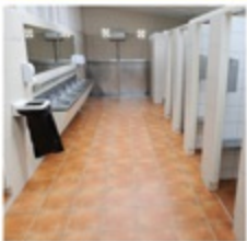
Los sanitarios, los aseos Toilet facilities
