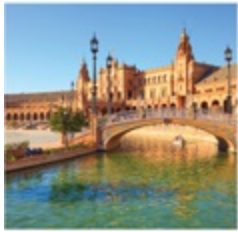
El puente Bridge
