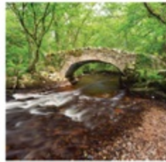
El puente Bridge
