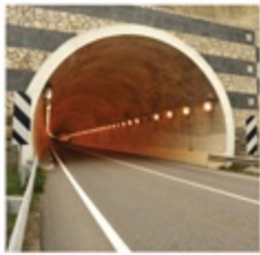
El túnel Tunnel
