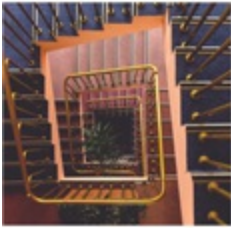
La escalera Stairs
