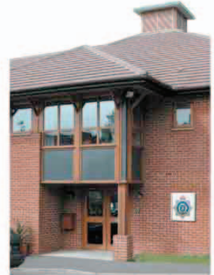
la estación de policía police station
