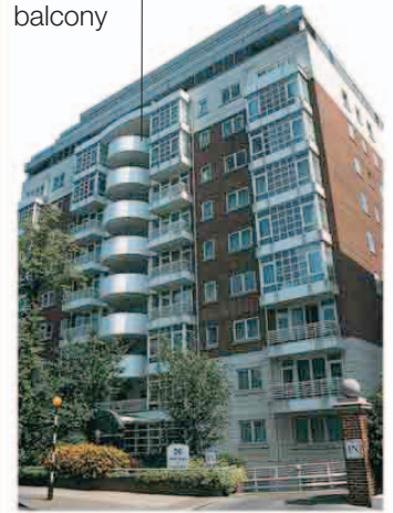
el edificio apartment block
