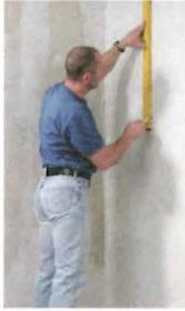
(1) Wand ausmessen und mit Wasserwaage Richtlinie auf die Wand zeichnen.
